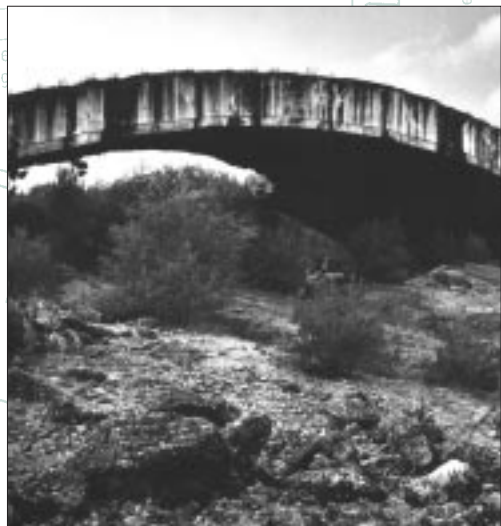
Mühlendorf, Reste der gesprengten Bunkerfabrik W. Nerdinger (Hg.): Bauen im Nationalsozialismus , München 1993
