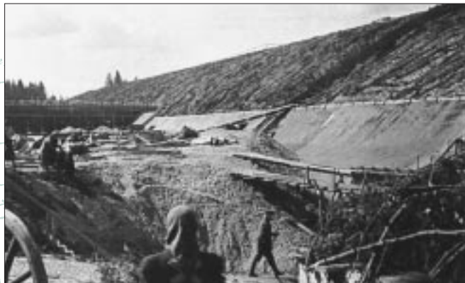
Bunkerbaustelle bei Kaufering (Häftling mit auf dem Rücken aufgemalten Zielpunkt für die Wachen) W. Nerdinger (Hg.): Bauen im Nationalsozialismus , München 1993
