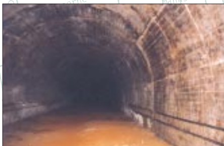
Stollen im "Doggerwerk" bei Happurg Foto: G. Faul
