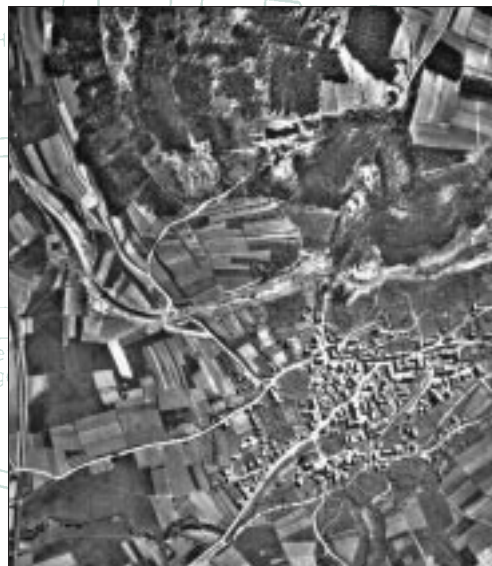
Detailsicht der Baustelle in Happurg vom 11.04.1945. Die Arbeiten waren zu diesem Zeitpunkt schon eingestellt Bild-Nr. 4033, Bildflug-Nr. 45 973/1, vom Bayer. Landesvermessungsamt genehmigt mit Nr. 2040/2001
